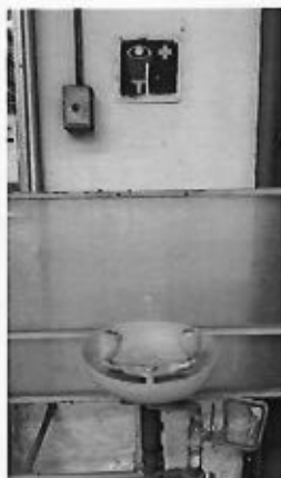
ภาพที่ 33 ฝักบัวและอ่างล้างตา
