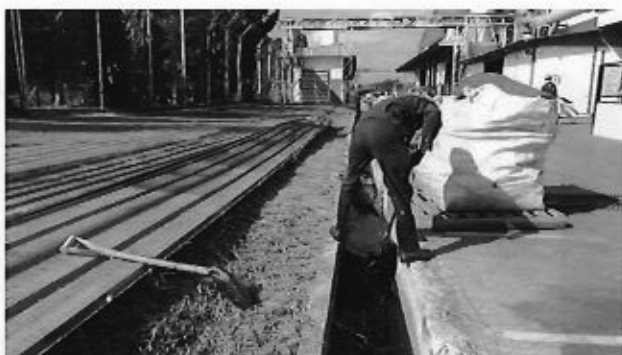
ภาพที่ 23 เจ้าหน้าที่ทำความสะอาดระบบระบายน้ำฝน
