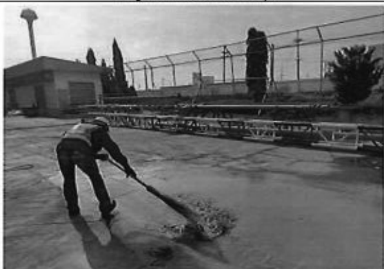
ภาพที่ 3 การฉีดพรมน้ำภายในพื้นที่ก่อสร้างและถนนที่ใช้ ขนส่งวัสดุอุปกรณ์
